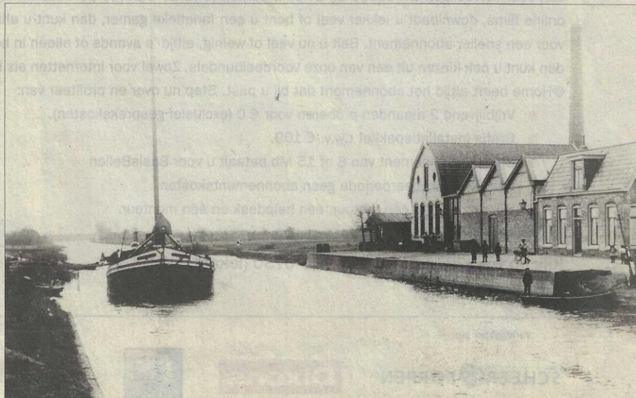
In 1906 werd deze foto gemaakt van de toen nog aanwezige zuivelfabriek aan het Kolonelsdiep te Kootstertille.
